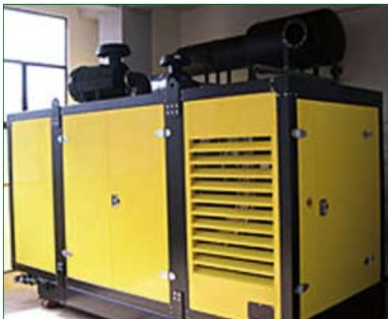
**Un "Trigeneratore" per un condomino, in grado di produrre energia elettrica, acqua calda per il riscaldamento e acqua fredda per il raffrescamento estivo. Può essere alimentato con gas naturale, biogas o biocombustibili.**
