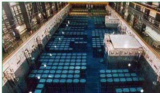
**Vasche di raffreddamento di combustibile nucleare irradiato nel complesso di La Hague in Francia. La luce blu è generata dalla radiazione di Cherenkov, che origina dalle particelle che si propagano a una velocità superiore alla velocità che la luce ha nell’acqua.**
